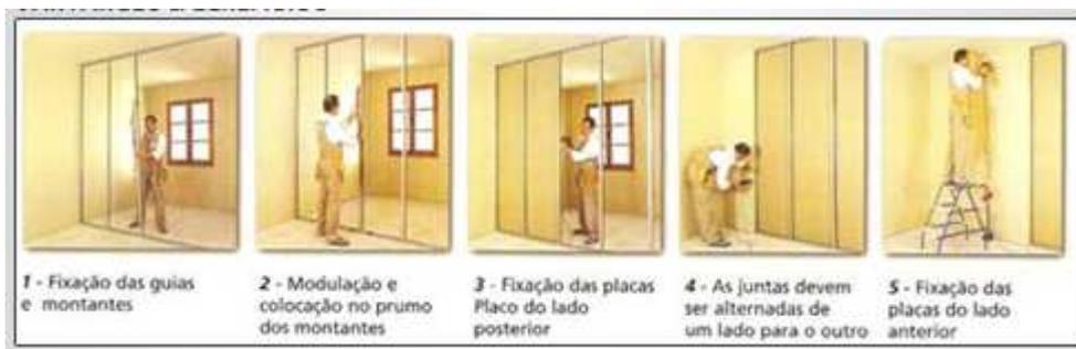
Foto 02 – Montagem da parede em Drywall
